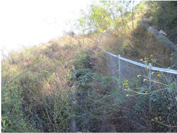
산마루측구, 점검계단 전경
