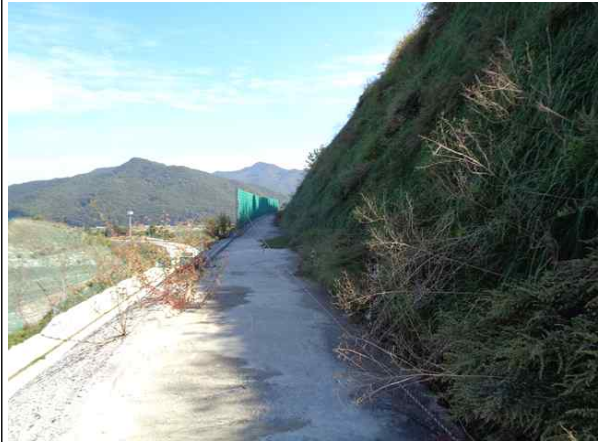
1소단 배수로 전경
