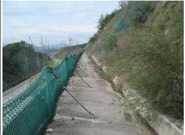
1소단 배수로 전경
