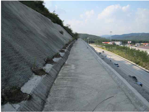
1소단 배수로 전경
