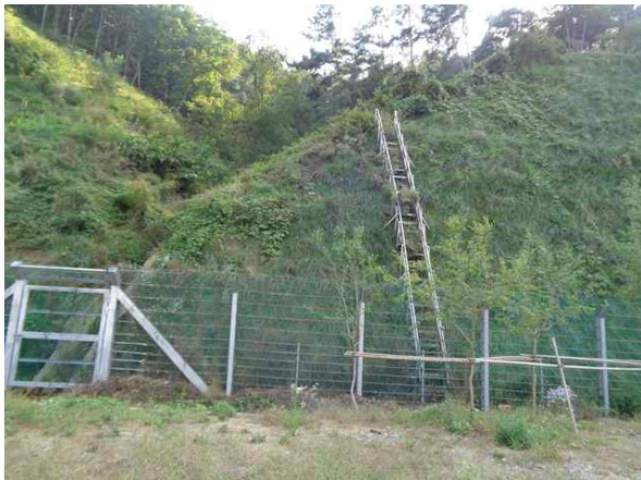
수직도수로, 점검계단 전경
