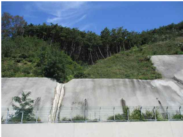
숏크리트, 수직도수로 전경
