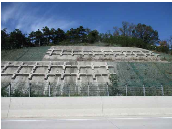
숏크리트, 격자블럭 전경
