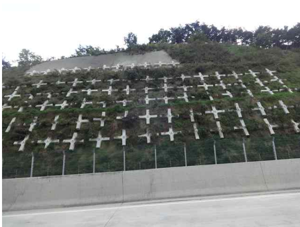
쑈크리트, 격자앵커 전경
