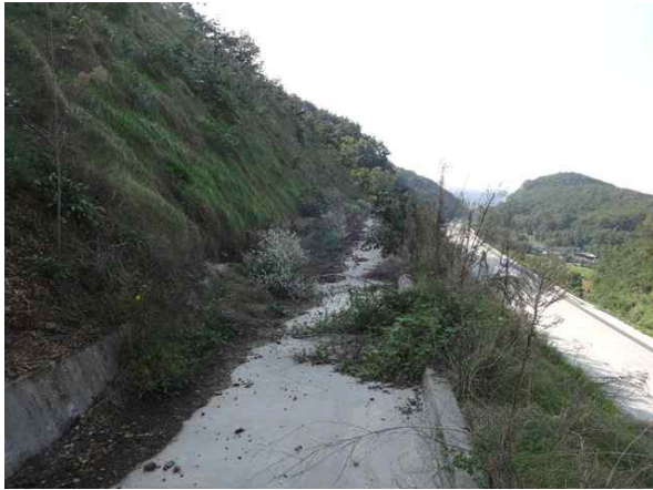
1소단 배수로 전경
