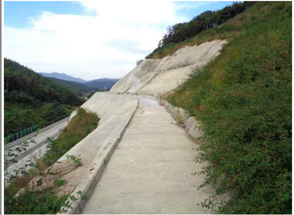
1소단 배수로 전경
