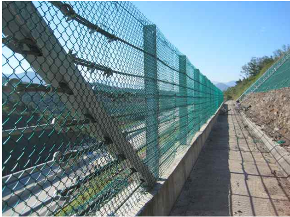
1소단 배수로 전경
