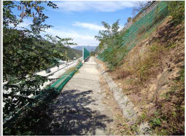
1소단 배수로 전경
