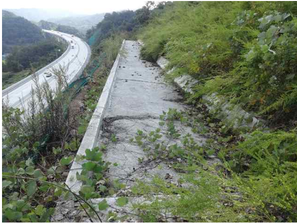
1소단 배수로 전경
