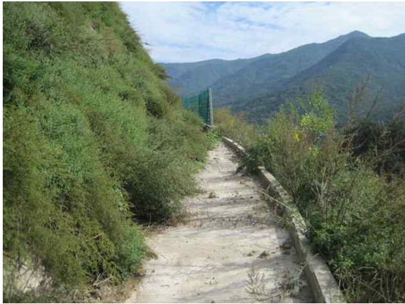
1소단 배수로 전경
