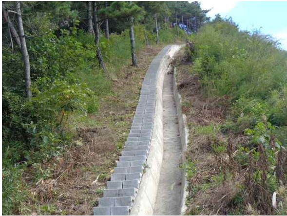
산마루측구, 점검계단 전경
