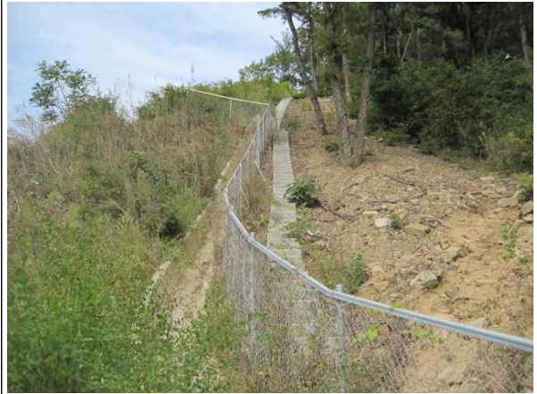
점점계단, 산마루측구 전경
