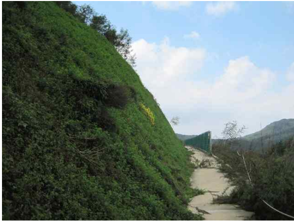
1소단 배수로 전경
