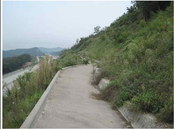
1소단 배수로 전경
