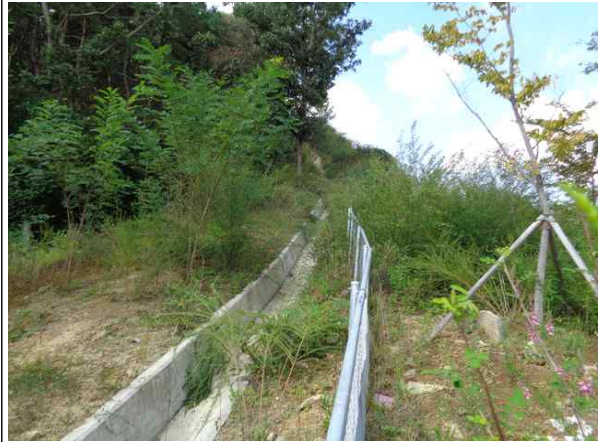
산마루측구, 야생동물유도울타리 전경
