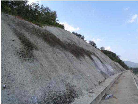
1소단 배수로 전경
