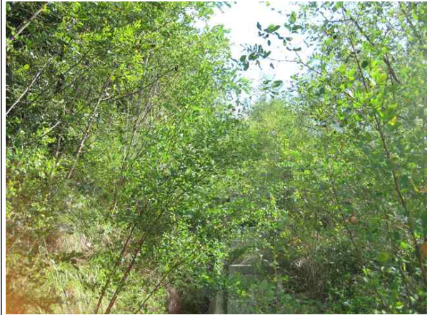
산마루측구, 점검계단 전경
