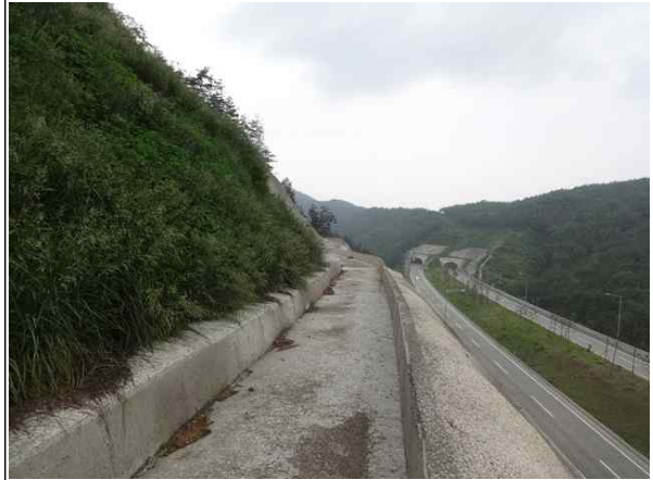
1소단 배수로 전경
