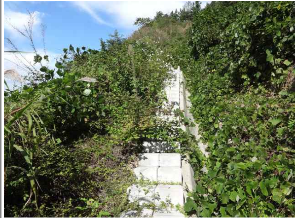
산마루측구, 점검계단 전경
