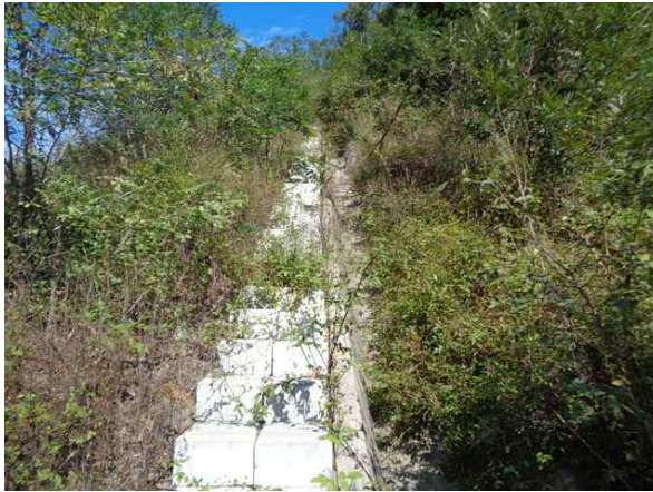
산마루측구, 점검계단 전경
