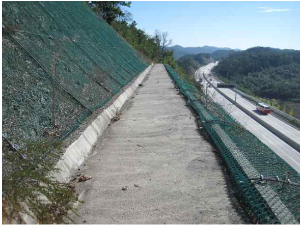
1소단 배수로 전경
