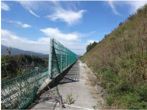
1소단 배수로 전경
