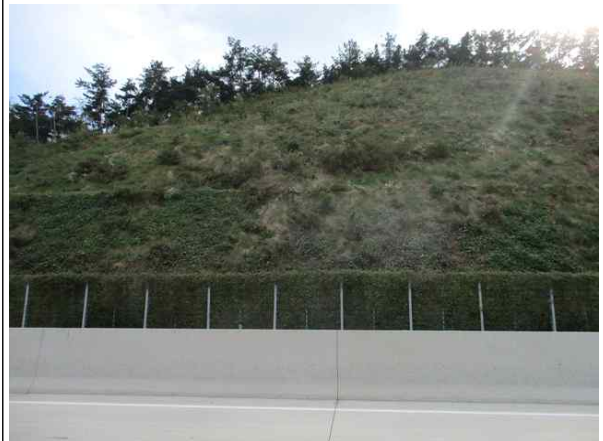
정면, 낙석방지울타리 전경
