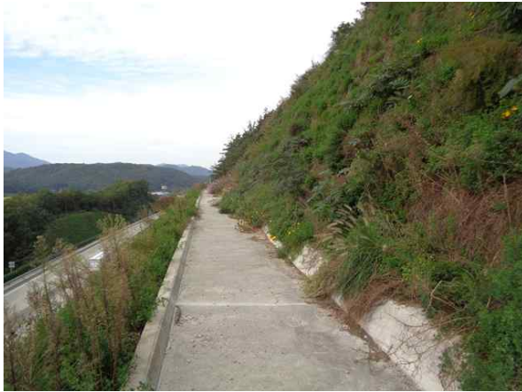
1소단 배수로 전경
