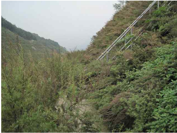
1소단 배수로 전경
