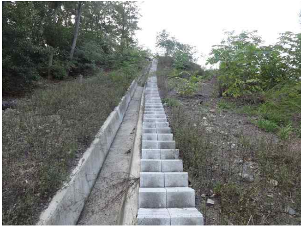
산마루측구, 점검계단 전경
