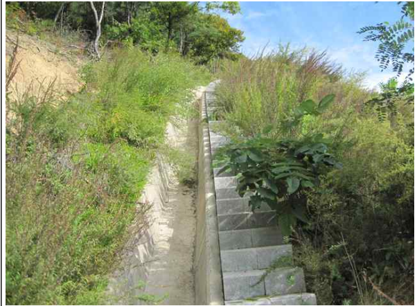
산마루측구, 점검계단 전경
