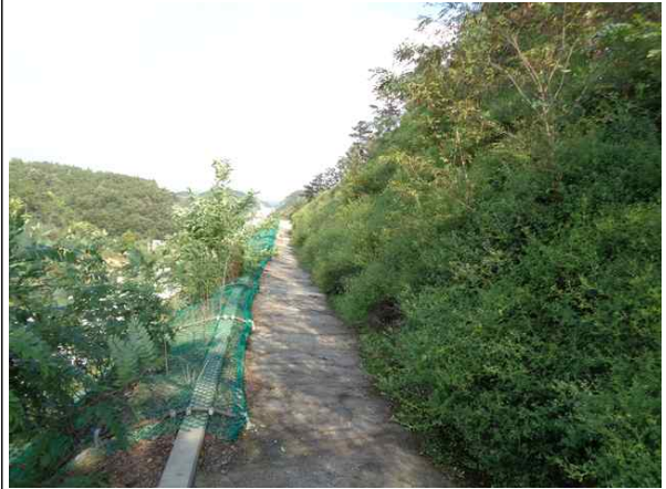
1소단 배수로 전경
