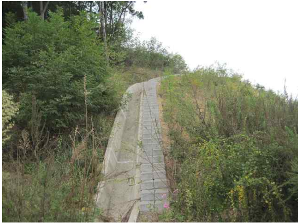
산마루측구, 점검계단 전경
