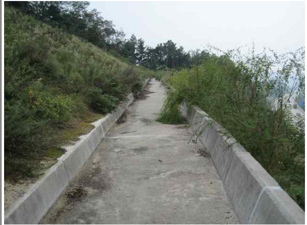
1소단 배수로 전경
