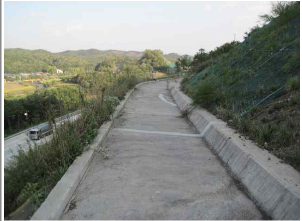
1소단 배수로 전경
