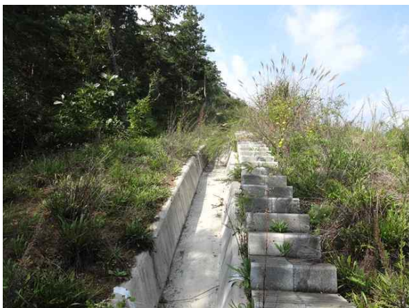
산마루측구, 점검계단 전경
