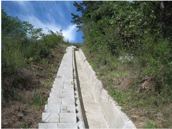
산마루측구, 점검계단 전경
