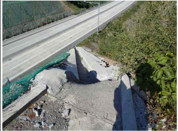
산마루측구, 점검계단 전경
