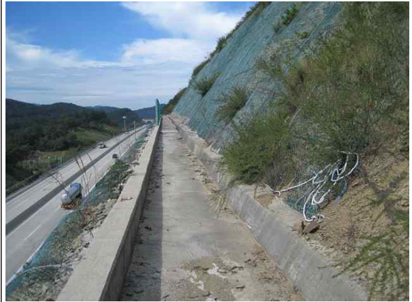
1소단 배수로 전경
