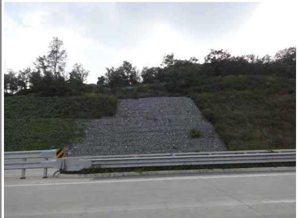
사면내 돌망태공 전경
