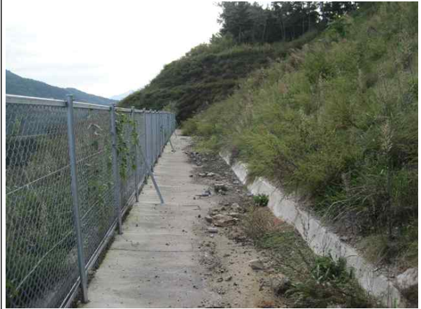
1소단 배수로 전경
