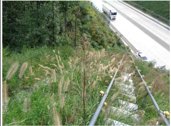
산마루측구, 점검계단 전경
