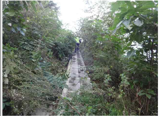
산마루측구, 점검계단 전경
