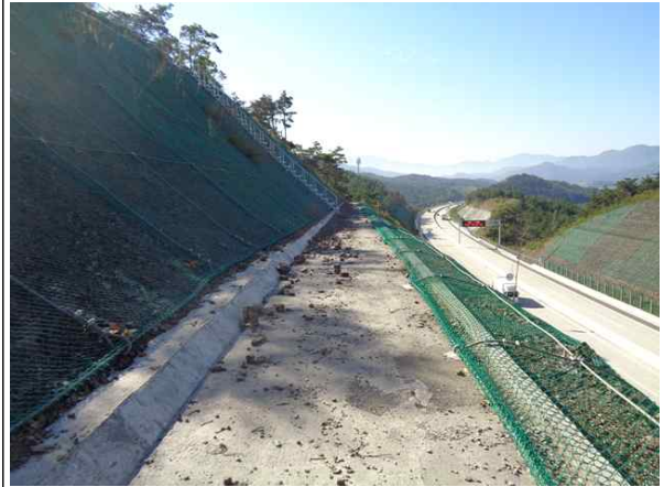
1소단 배수로 전경
