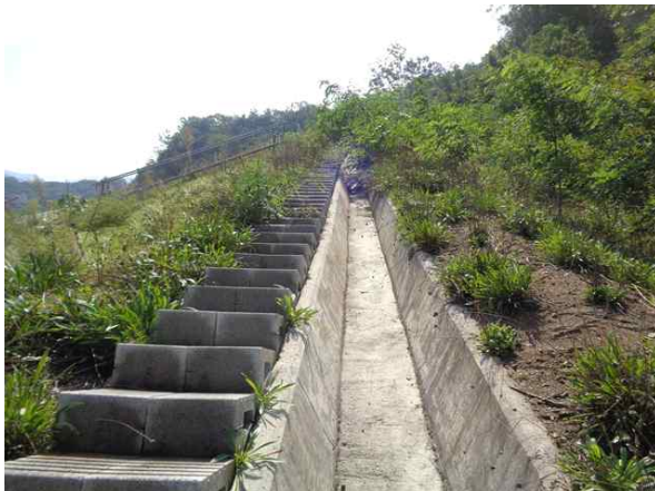
산마루측구, 점검계단 전경
