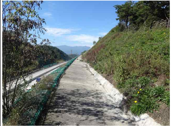
1소단 배수로 전경
