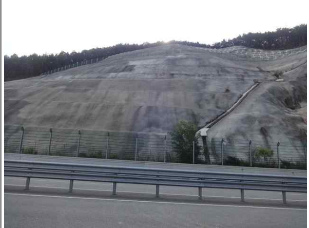
쑥크리트, 격자블럭 전경
