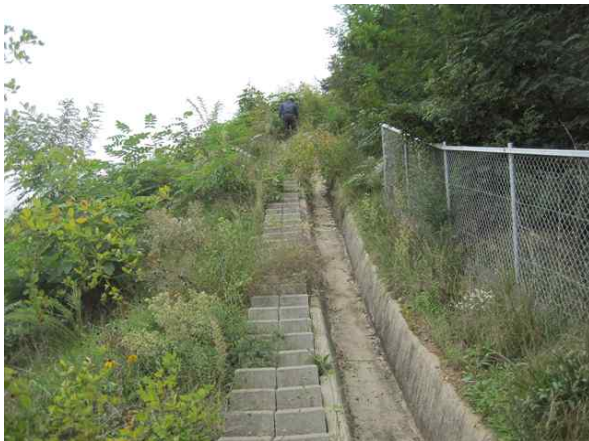
산마루측구, 점검계단 전경
