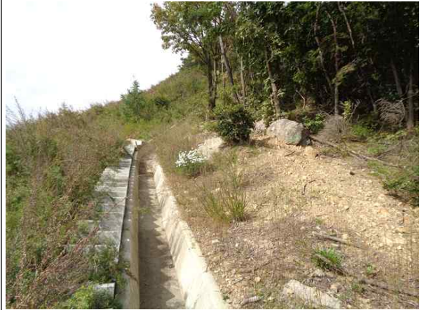
산마루측구, 점검계단 전경
