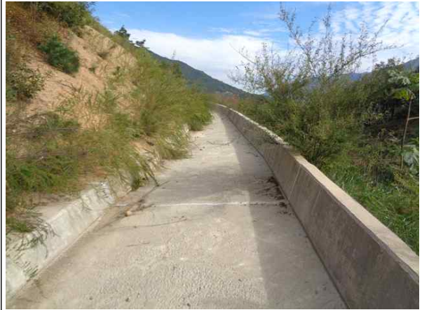
1소단 배수로 전경
