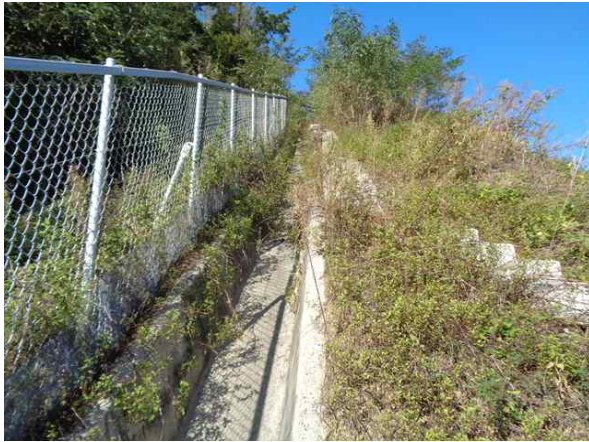
산마루측구, 점검계단 전경
