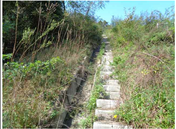
산마루측구, 점검계단 전경
