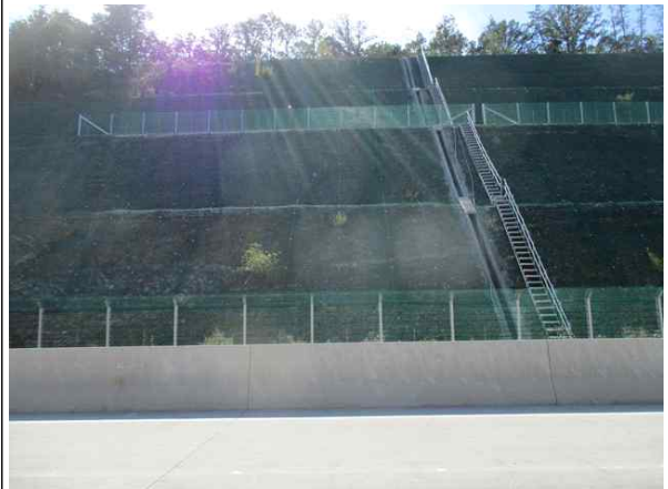
수직도수로, 점검계단 전경
