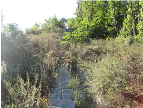
산마루측구, 점검계단 전경
