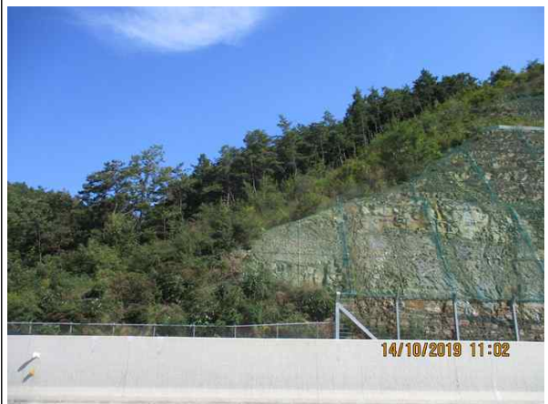
야생동물유도울타리, 낙석방지망 전경
