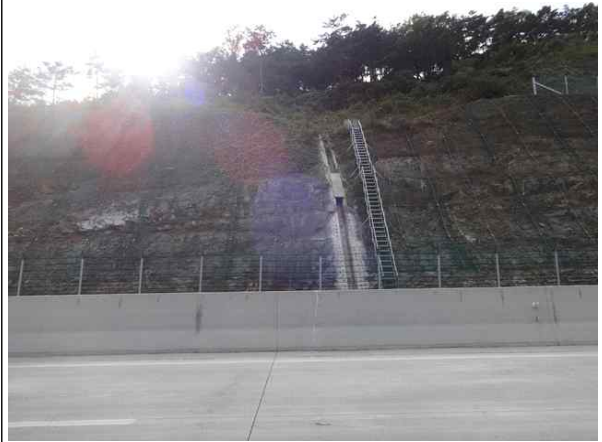
수직도수로, 점검계단 전경
