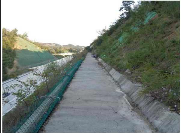
1소단 배수로 전경
