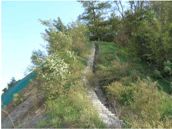
산마루측구, 점검계단 전경
