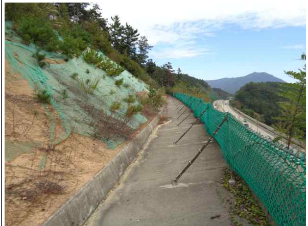
1소단 배수로 전경
