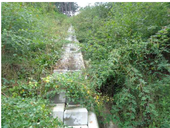
산마루측구, 점검계단 전경
