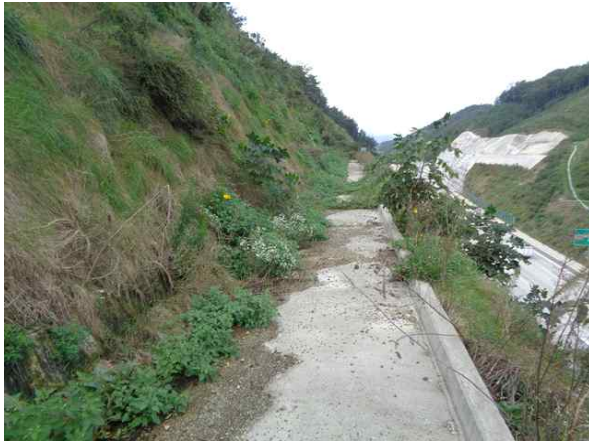
1소단 배수로 전경
