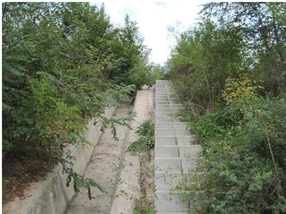
산마루측구, 점검계단 전경
