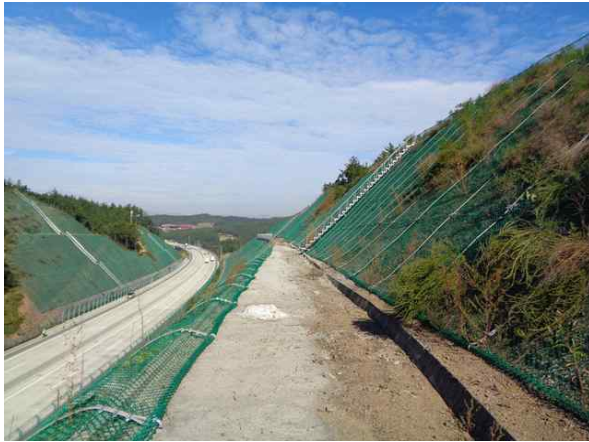
1소단 배수로 전경
