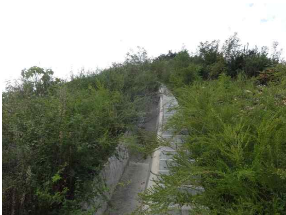
산마루측구, 점검계단 전경
