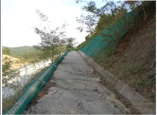
1소단 배수로 전경
