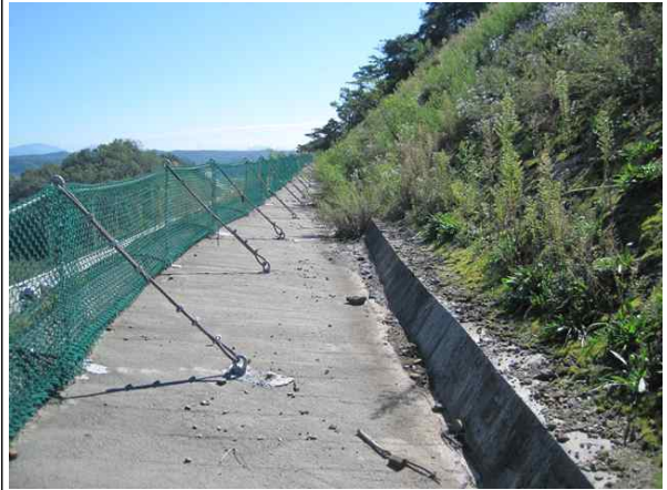
1소단 배수로 전경
