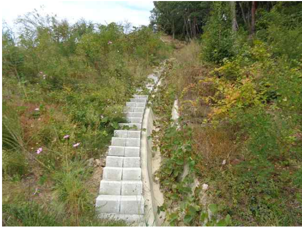
산마루측구, 점검계단 전경
