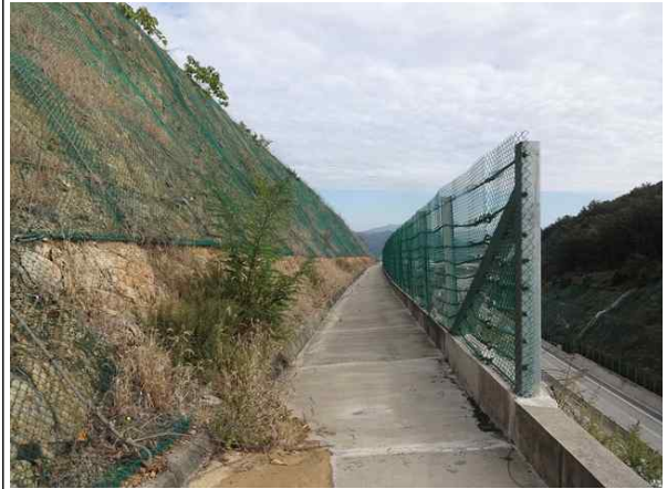
1소단 배수로 전경
