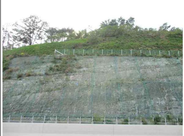
낙석방지망, 낙석방지울타리 전경
