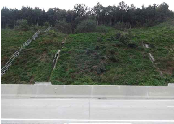
수직도수로, 점검계단 전경
