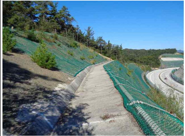
1소단 배수로 전경
