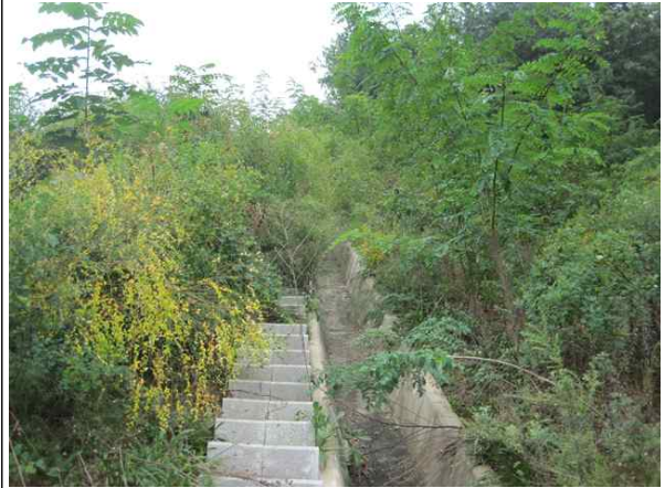
산마루측구, 점검계단 전경
