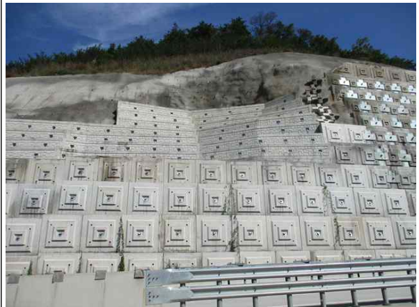
사면내 옹벽 전경
