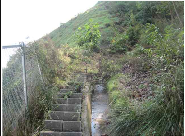
산마루측구, 점검계단 전경
