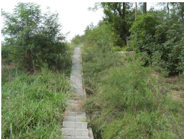
산마루측구, 점검계단 전경
