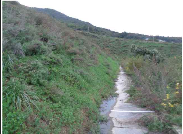
1소단 배수로 전경
