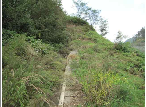
산마루측구, 점검계단 전경
