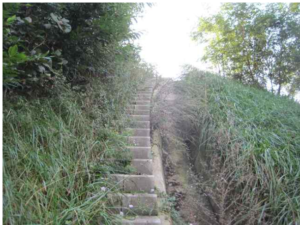
산마루측구, 점점계단 전경
