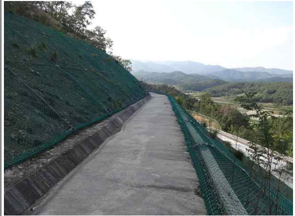
1소단 배수로 전경
