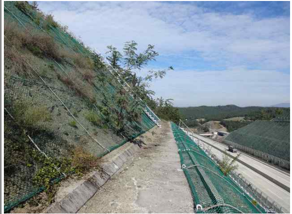
1소단 배수로 전경
