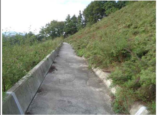
1소단 배수로 전경
