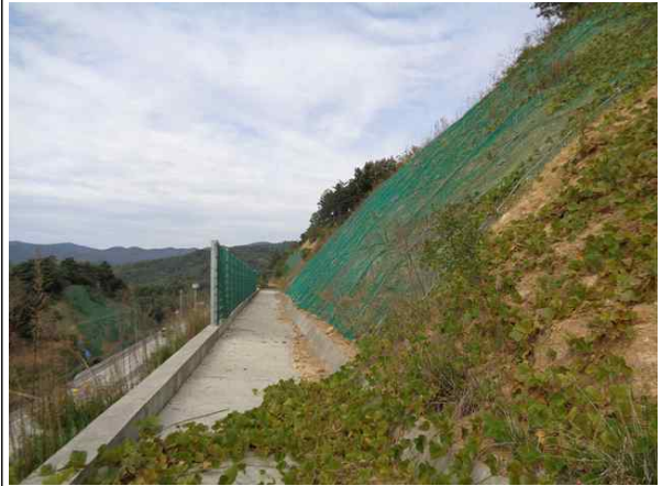
1소단 배수로 전경
