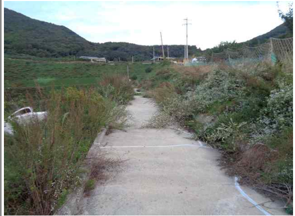
1소단 배수로 전경
