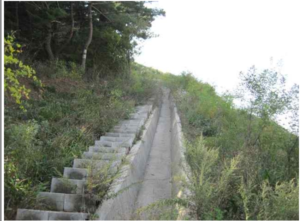
산마루측구, 점검계단 전경
