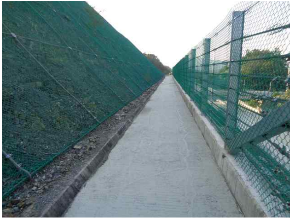
1소단 배수로 전경
