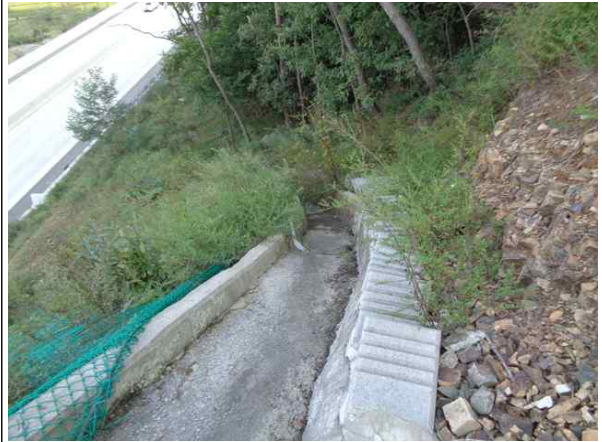
산마루측구, 점검계단 전경
