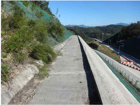
1소단 배수로 전경
