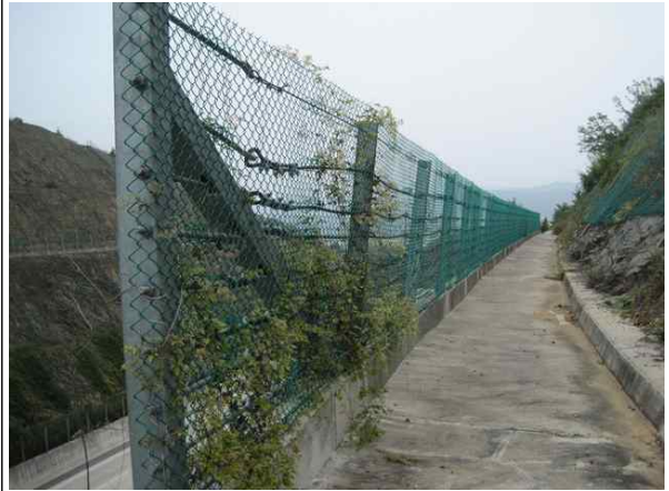
1소단 배수로 전경
