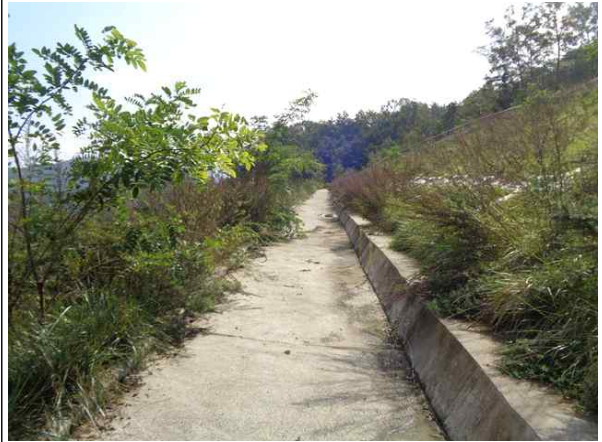
1소단 배수로 전경
