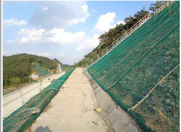
1소단 배수로 전경
