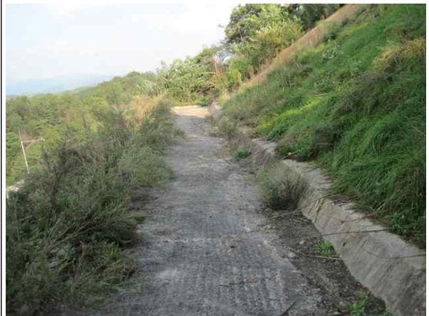
1소단 배수로 전경
