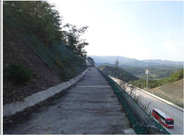
1소단 배수로 전경
