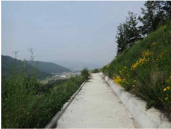
1소단 배수로 전경
