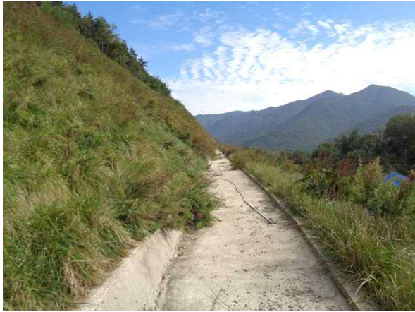
1소단 배수로 전경
