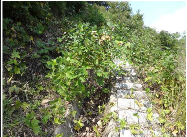
산마루측구, 점검계단 전경
