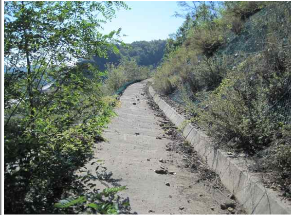
1소단 배수로 전경
