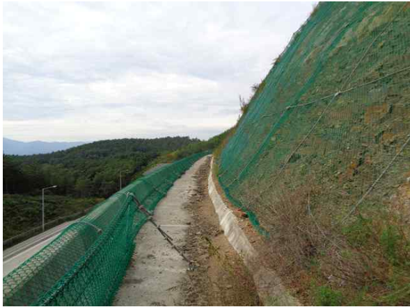
1소단 배수로 전경
