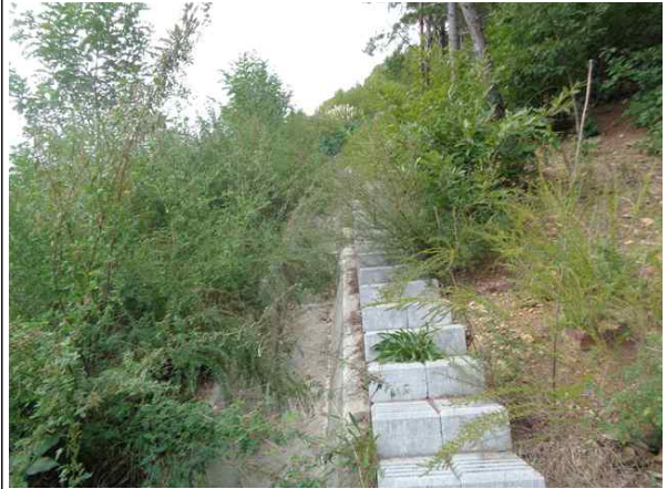
점점계단, 산마루측구 전경
