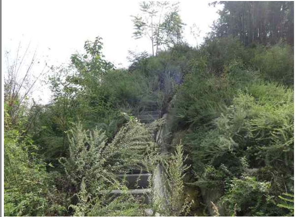
점점계단, 산마루측구 전경
