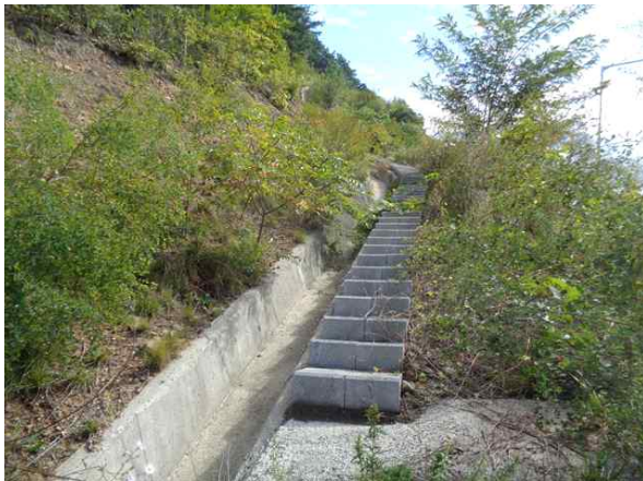
산마루측구, 점검계단 전경
