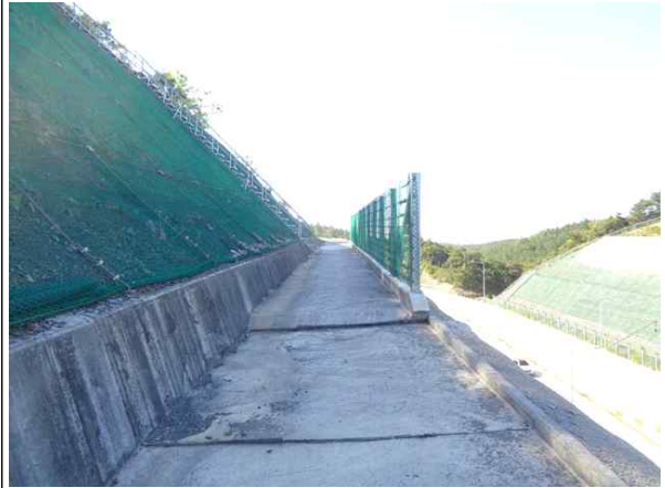
1소단 배수로 전경
